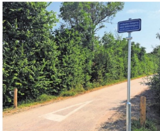
▲ Het bordje 'verboden toegang' aan het begin van de Havenweg. Vanwege werkzaamheden is doorrijden nu echt niet meer mogelijk.
